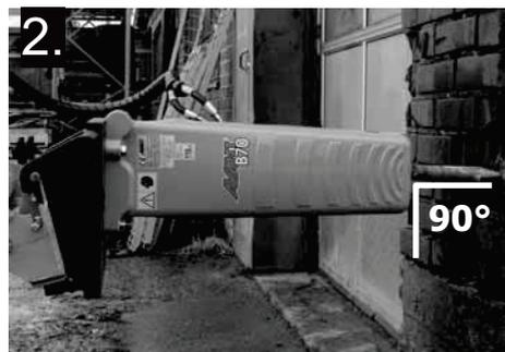
5. Lors de la démolition de structures verticales (par exemple des murs de brique), placez l'outil contre le mur, à 90 degrés par rapport à celui-ci (voir image 2).
